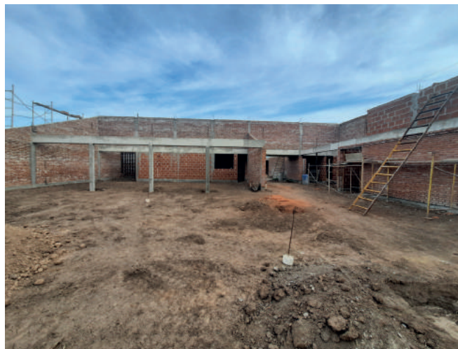
Bouwwerkzaamheden hoofdkantoor Casita del niño Rincón del Sol.
